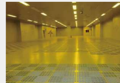
某社クリーンルーム設備工事
