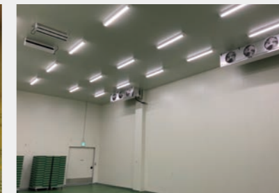
某冷蔵・冷凍庫設備工事
