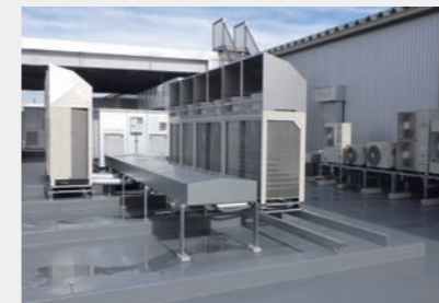
某社空調設備工事
